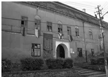
Apafi kastély főbejárata
